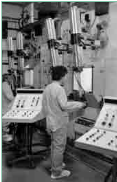
Protección del trabajador: celda blindada con telemanipuladores
